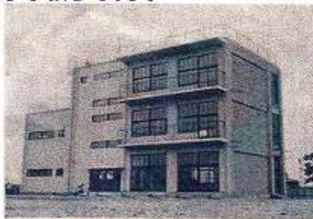
昭和35年第1期工事しゅん工当時
